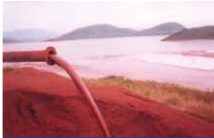
Şekil 2: Kırmızı çamur barajı
